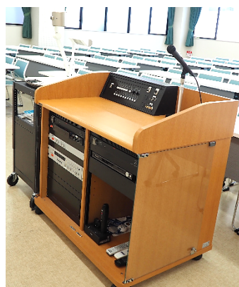
教室前方に操作台を設置（映像・音響・書画カメラ）
